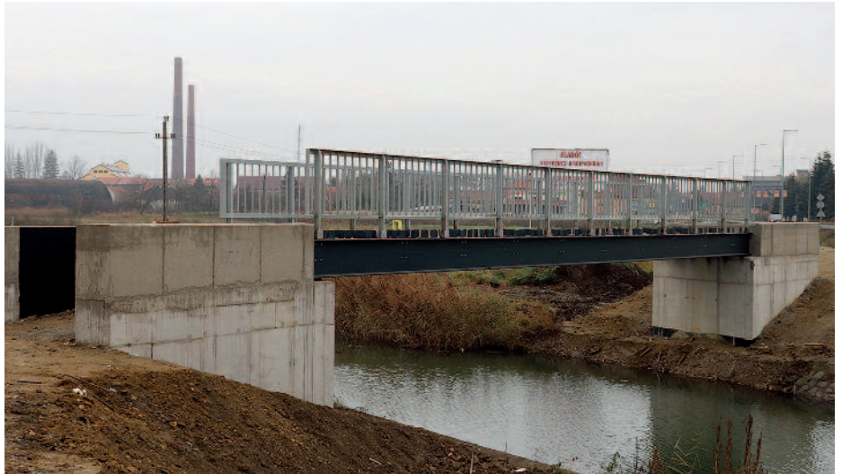
Helyére került a híd acélszerkezete.
