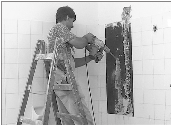
A Rákóczi iskolában a vízvezetékek cseréjét is elvégezték.
