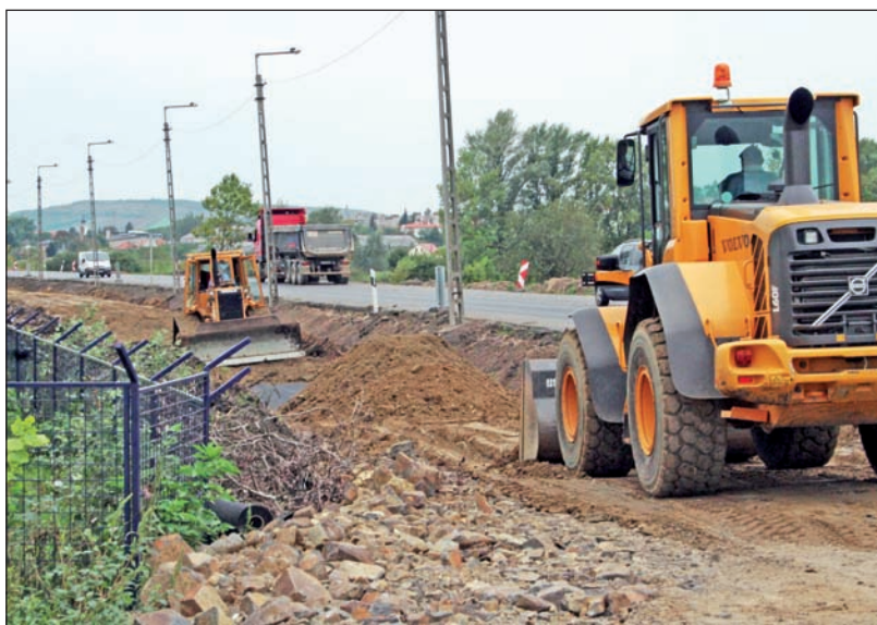
A város Sátoraljaújhely felőli bejáratánál dolgoznak a munkagépek.
